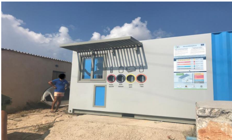
Τ.Κ. Ηρακλειάς (Θέση Λιβάδι)
